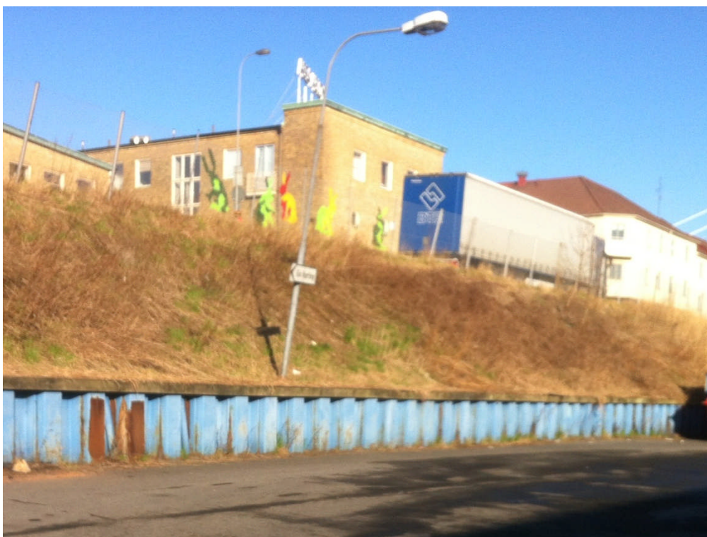
Figur 4 Sned lyktstople som står direkt ovanför spont.
