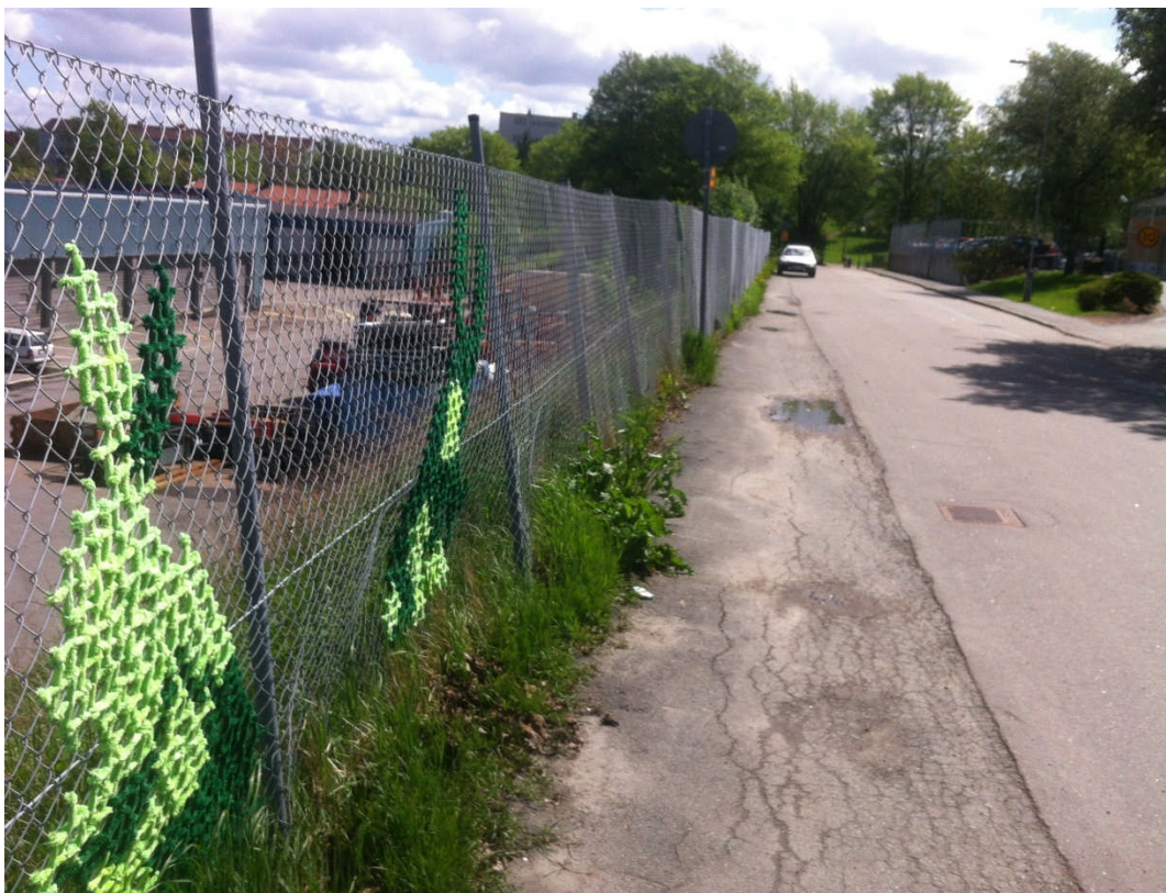
Figur 5 Sprickor i gata samt lutande staketstolpar. Utanför varuintag.
